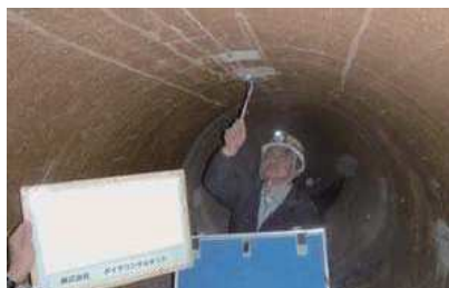
管頂部における測定状況
