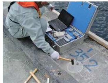
護岸鋼矢板の設置深度調査事例
