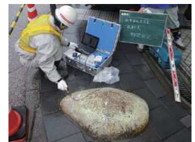
杭の健全度調査・診断事例
