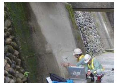
橋台の形状寸法調査事例
