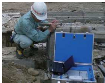
ダムの健全度調査・診断事例
