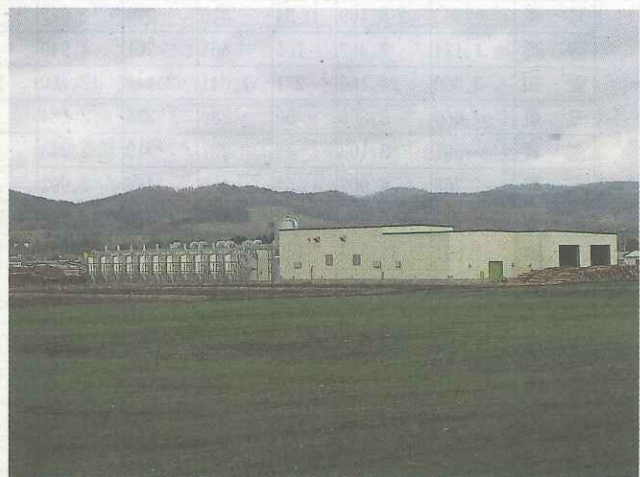
ガス化装置を連結している下川発電所
