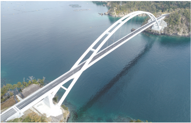
アーチ曲線が美しい出島大橋
