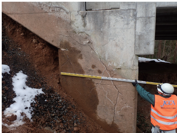
写真-3 被災した道路構造物の詳細調査状況
