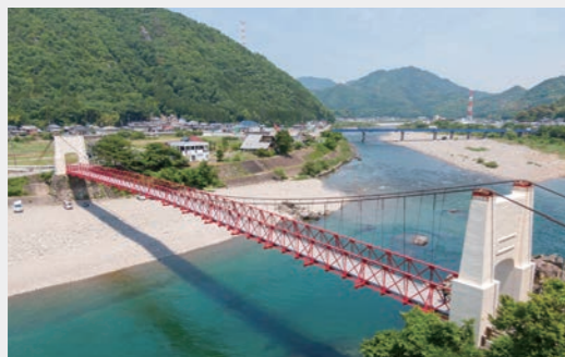
国内最古の近代吊り橋として国の重要文化財に指定されている「美濃橋」
