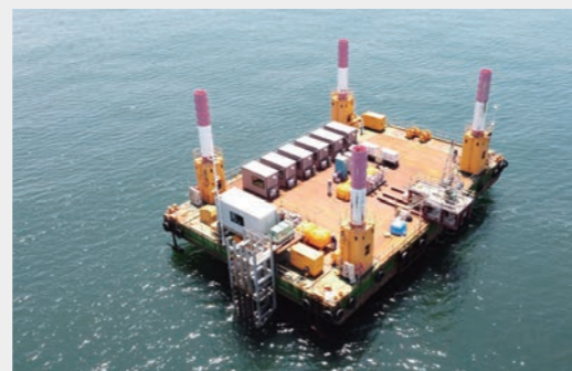
海上ボーリング調査
