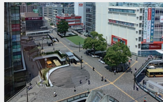
軽量化の工夫によってリニューアルされた「藤沢駅北口デッキ」
