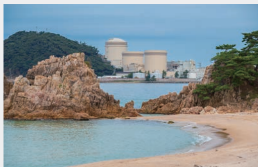
原子力発電施設での調査
