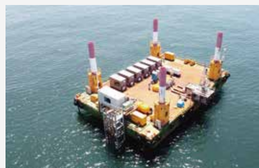
海上ボーリング調査
