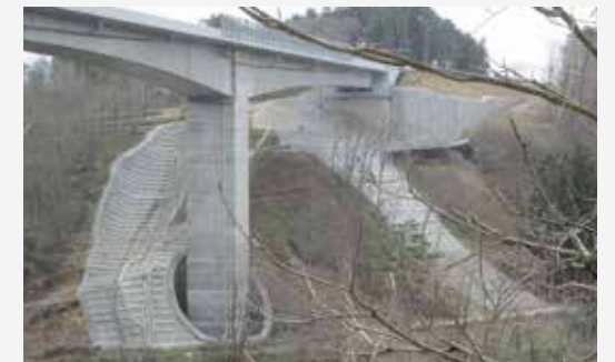
東日本大震災で被災した斜面の復旧対策設計(橋台取付部ののり面対策)
